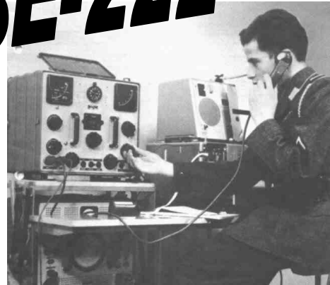
Kurzwellen-Funkstation SE-222 mit Krypto-Funk-Fernschreiber KFF (1959)
