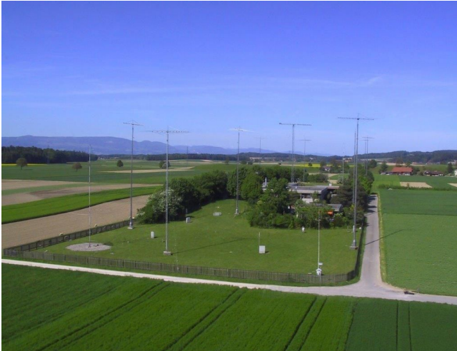
Mittellandzentrale Murain bei Ersigen BE
