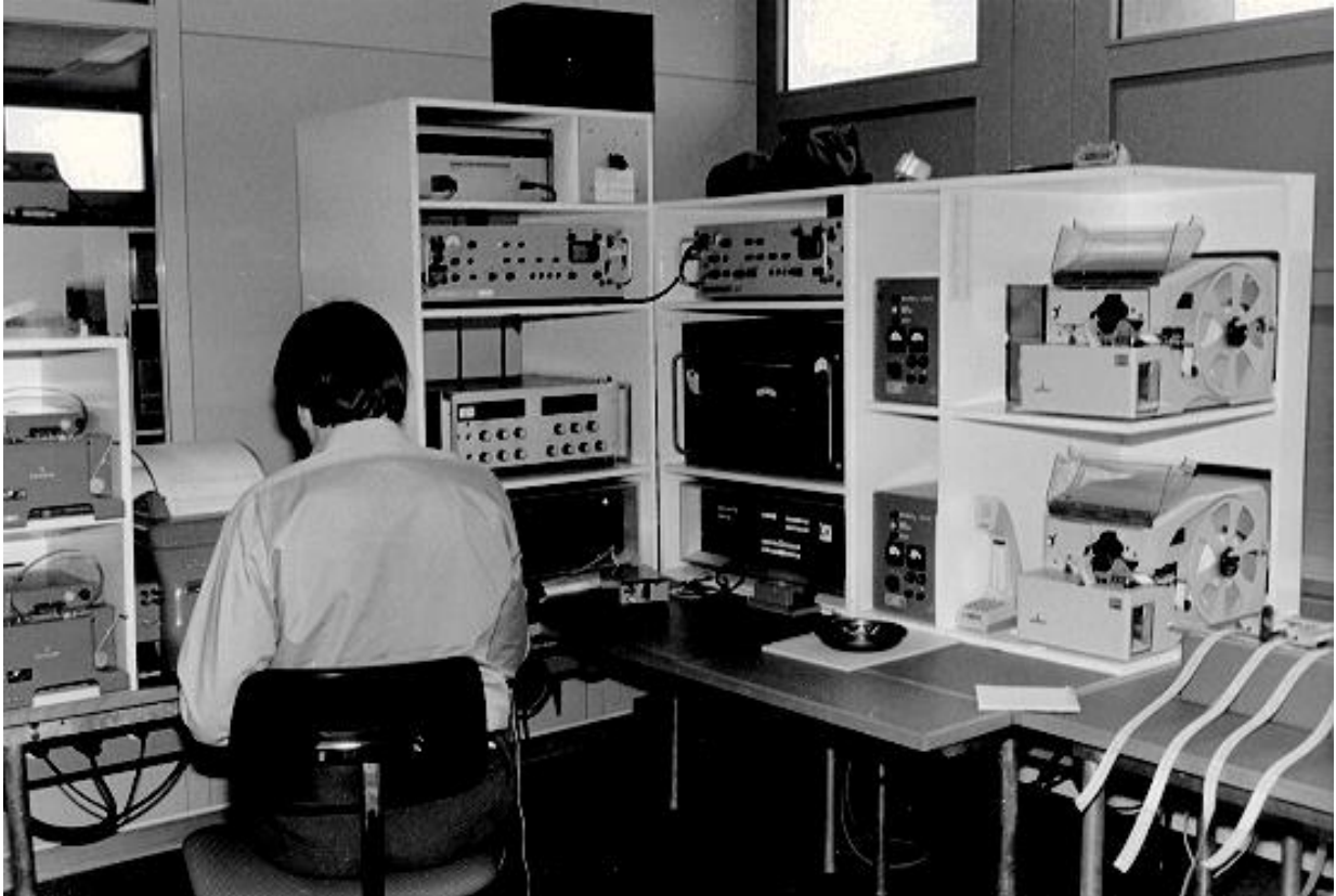
Eine F6 Funkfernsehreibanlage in der Mittellandzentrale Murain
