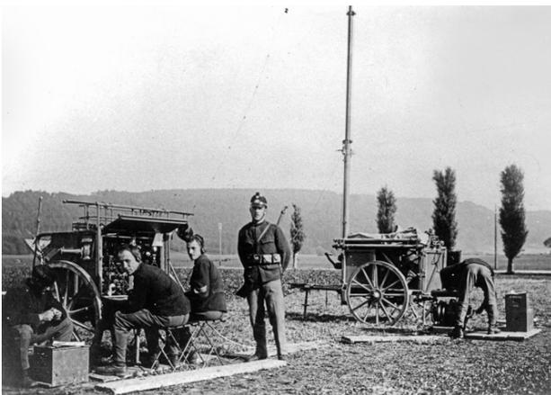
Funkstation Sender/Empfänger links, Zubehörcarren rechts
